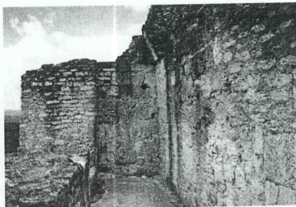
Foto 7. Edificio 216, Cámara Oeste
