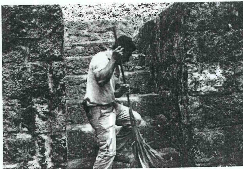
Foto 3. Basamento del Grupo Residencial Oeste durante los trabajos de limpieza
