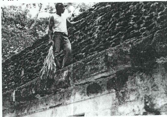
Foto 5. El trabajo en la Acrópolis Sur exige poner atención al más mínimo detalle. En este caso se está atendiendo el techo del Edificio 375
