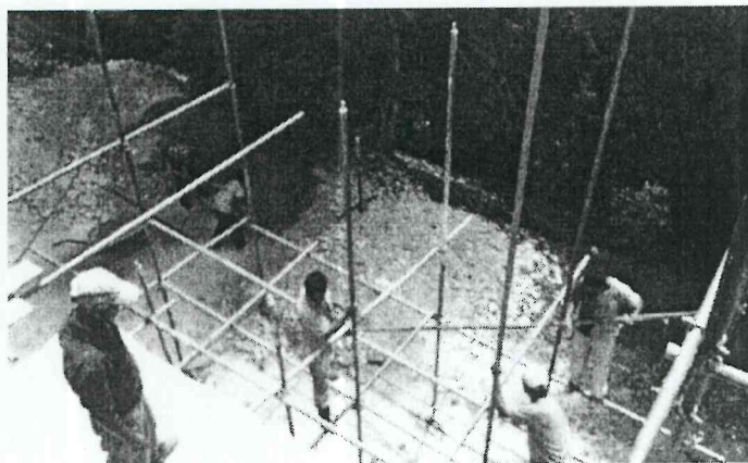
Foto 9. Edificio 137, lado Norte durante los trabajos
